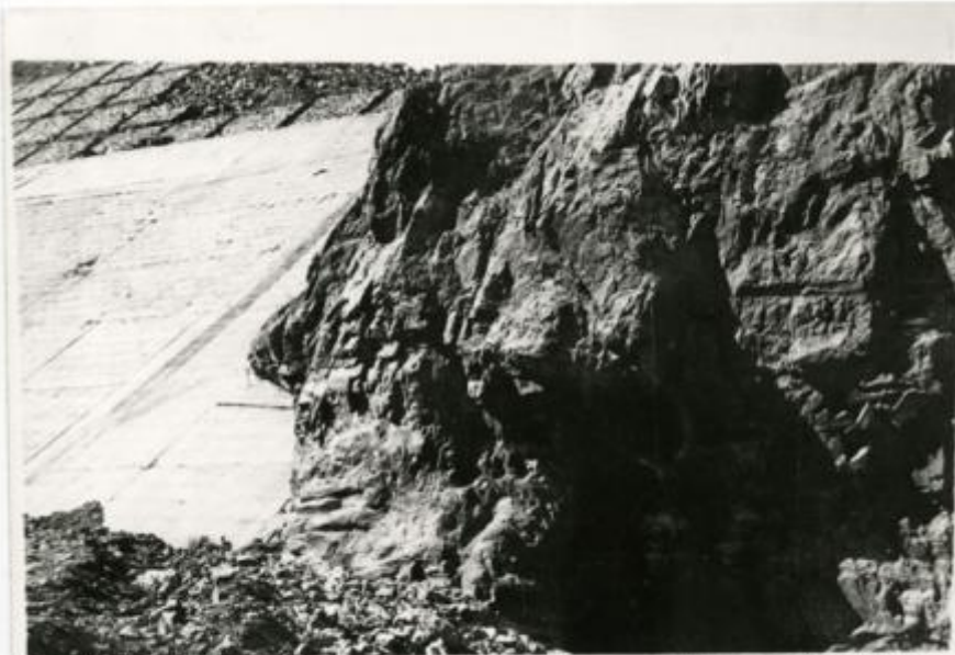
Embalse Cogotí.- Boca entrada al túnel y parrilla concreto a monte.
